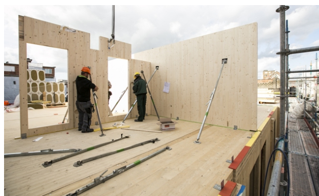
InDruk is een bio-ecologisch bouwproject. Zo wordt er voor de ruwbouw gebruik gemaakt van massief houten platen, genaamd CLT. FOTO DIRK KERSTENS
